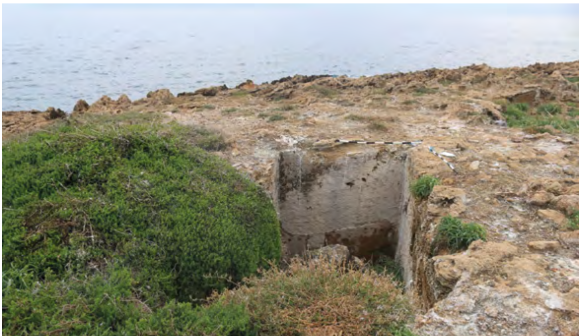
Рис. 47. Остров Эль Аббас. Цистерна в юго-восточной части острова, вид с севера.
