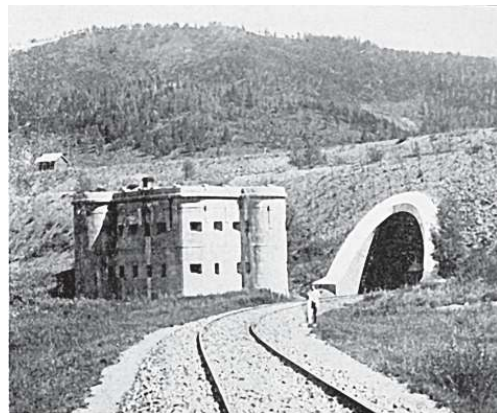
Хинганский тоннель (Кормазов, 1934).
